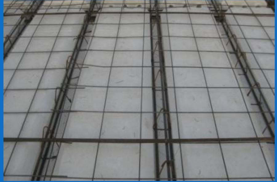
تركب مشبكات الحديد للطبقة العليا (BRC) وهو حديد لمقاومة التمدد الحراري ولا يعمل انشائيا
