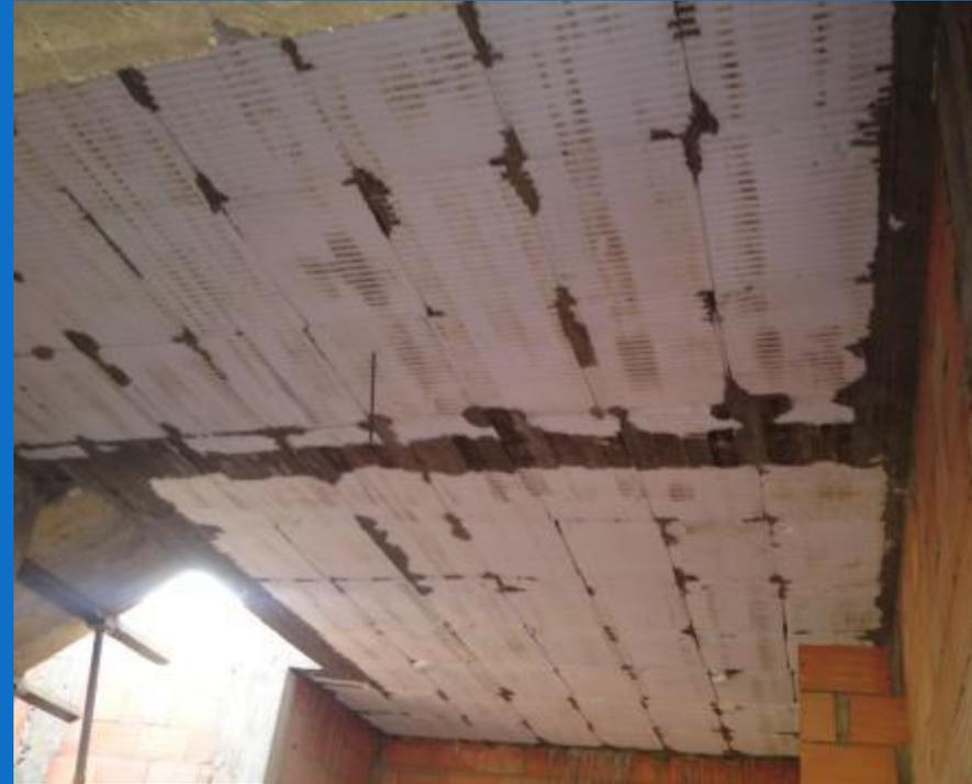
1. يمكن فتح القالب بعد فترة قصيرة بسبب خفة وزن السقف بهذا النظام مقارنةً بالنظام التقليدي
